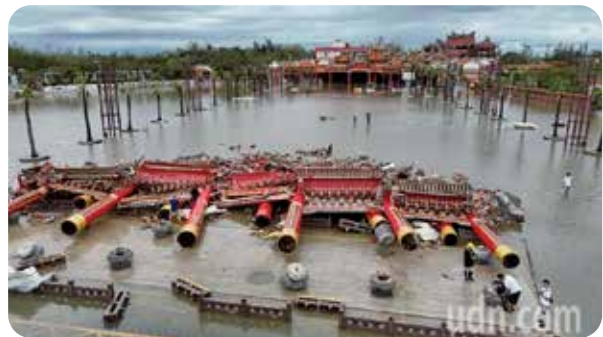
▲2025年7月丹娜絲颱風：台南北門區南鯤鯓代天府門前超過40年的牌樓、總計12支粗壯牌樓竟被吹倒(記者劉學聖/攝影)。
