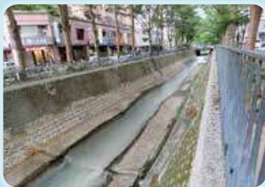
▼潮洋溪改善前。
