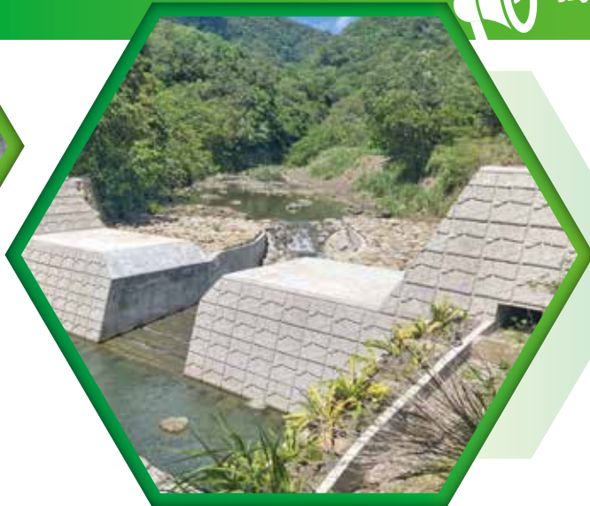
▲雙流溪壩體改善工程。
