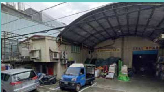
A5220 新北頂崁光復乙工廠房 土地面積：404 坪
