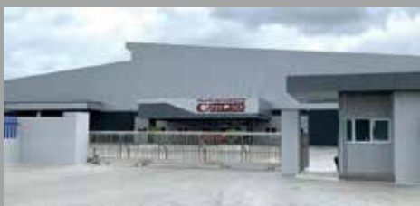
銘倫精機卡力歐泰國廠房新建工程 CARLEO FACTORY PROJECT
