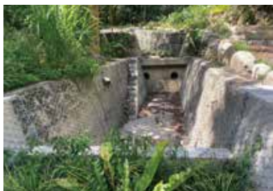
▲白榕步道坑溝完工現況。
