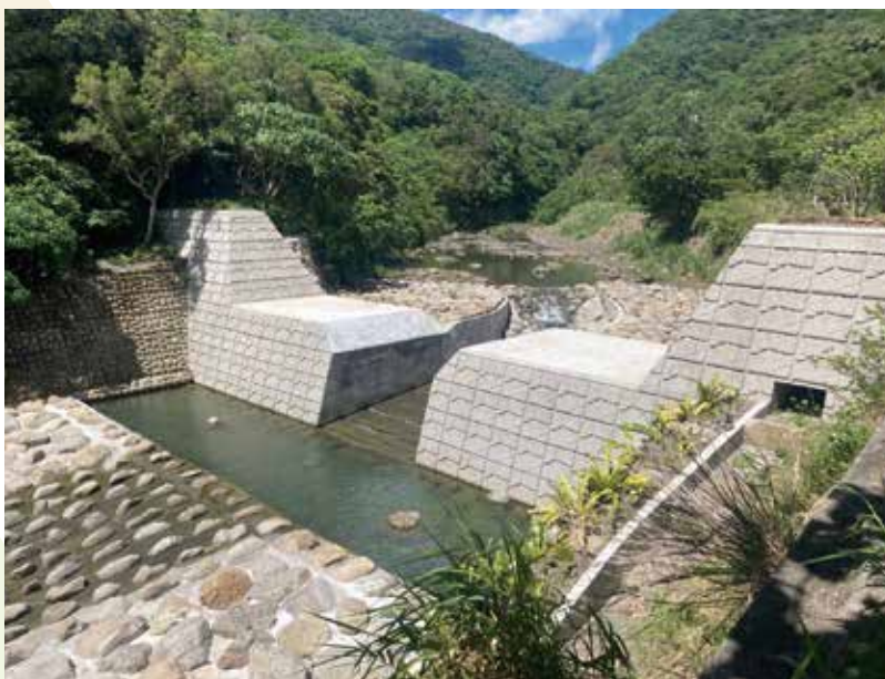
▲雙流溪既有防砂壩改善完工現況。
